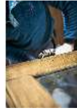
Neusch.II, Restaurierung und Instandhaltung, DI017073, BSV-
