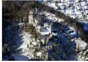
Neusch.I, Luftaufnahme, Blick nach Westen, DI002143, BSV
