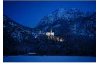
Neusch.I, Gesamtaufnahme der Nordfassade, verschneit beleuchtet, DI006315, BSV-
