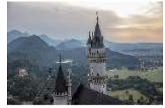
Neusch.I, Luftaufnahme, Treppenturm, DI010616, BSV
