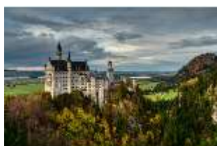
Neusch.I, Südfassade im Herbst, DI015508, BSV
