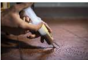
Neusch.II, Restaurierung und Instandhaltung, DI017066, BSV-
