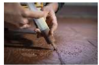
Neusch.II, Restaurierung und Instandhaltung, DI017065, BSV-
