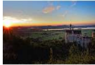
Neusch.I, Gesamtaufnahme der Südfassade mit Sonnenuntergang, DI006314, BSV-
