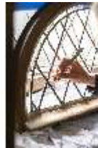
Neusch.II, Restaurierung und Instandhaltung, DI017080, BSV-
