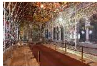
Neusch.II, Sängersaal, Sanierung 2018, DI013711, BSV-
