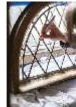
Neusch.II, Restaurierung und Instandhaltung, DI017081, BSV-
