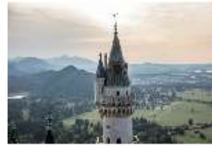
Neusch.I, Luftaufnahme, Treppenturm, DI010615, BSV
