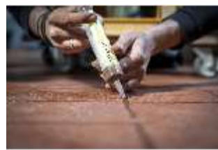
Neusch.II, Restaurierung und Instandhaltung, DI017063, BSV-
