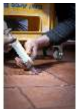
Neusch.II, Restaurierung und Instandhaltung, DI017062, BSV-
