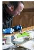
Neusch.II, Restaurierung und Instandhaltung, DI017068, BSV-
