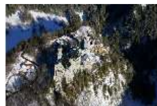
Neusch.I, Luftaufnahme, Blick nach Norden, DI002144, BSV
