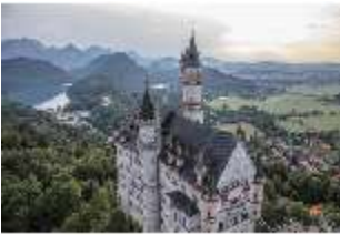
Neusch.I, Luftaufnahme, Treppenturm, DI010617, BSV
