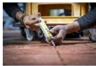
Neusch.II, Restaurierung und Instandhaltung, DI017064, BSV-
