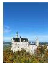
Neusch.I, Südfassade, Schloss, Blick von Süden, DI028079, BSV
